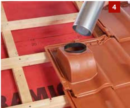
4 Gasthermen Luft-/Abgasrohr (nicht im Lieferumfang enthalten) durch den Durchgangsziegel bis zum Anschlag einschieben.
