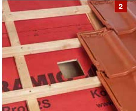
2 Öffnung in erforderlicher Größe an markierter Stelle in der Unterkonstruktion mit geeignetem Werkzeug herstellen.
