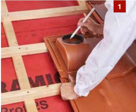
1 Position der Durchführungsöffnung mit Hilfe des Durchgangsziegels auf der Unterkonstruktion anzeichnen.
