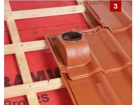
3 Durchgangsziegel eindecken und ggf. gegen Windsog sichern.
