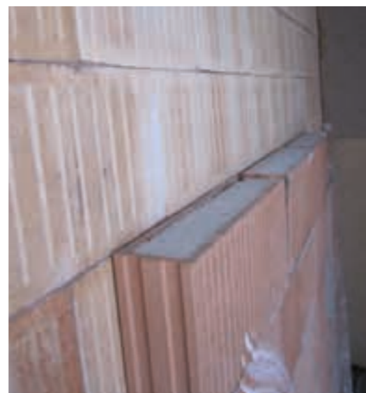
Im Eingangsbereich wurde zusätzlich gedämmt. Mit der massiven Wärmedämmfassade Poroton-WDF ist die Oberfläche dabei besonders robust.
