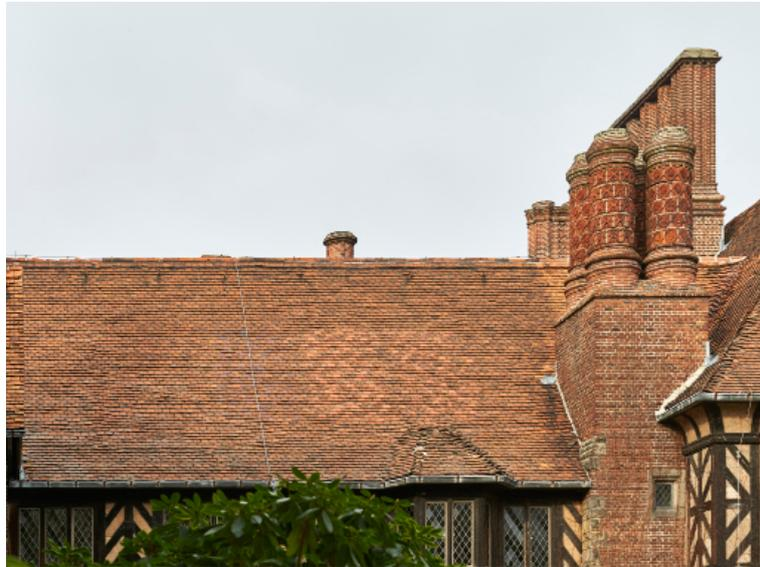
Aktuelle Sanierungsarbeiten auf einer Dachfläche des Schlosses Cecilienhof in Potsdam, wo speziell für dieses Rekonstruktionsmaßnahme Biberschwanzziegel von der Wienerberger Manufaktur-Werkstatt hergestellt werden.
